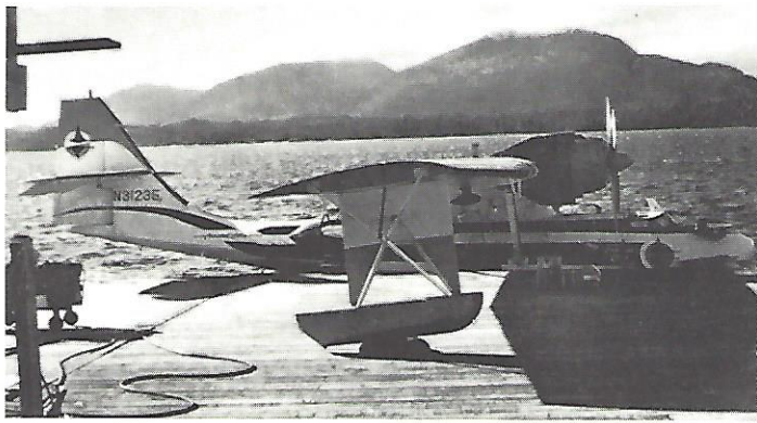
PBY-5A mit modifiziertem Seitensteuer der "Costal Ellis" Fluggesellschaft in Alaska.
